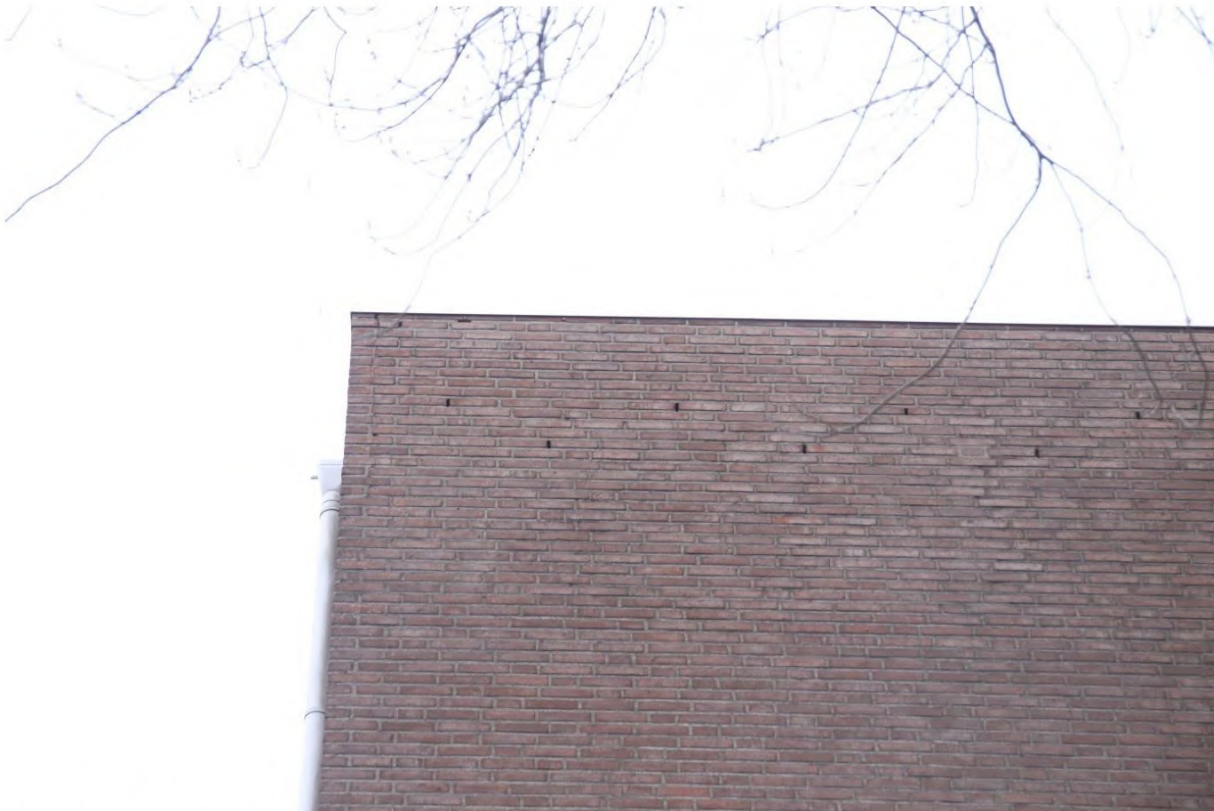
Foto 6: Er zijn aan weerszijden van het gebouw open stootvoegen aanwezig die dienst kunnen doen als toegang tot achterliggende spouwmuur voor vleermuizen, waardoor gebouwbewonende vleermuissoorten vaste rust- en verblijfplaatsen kunnen hebben.
